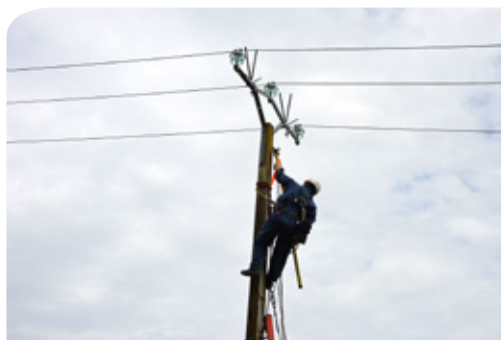
Equipement d'un dispositif avifaune sur un support HTA par un technicien Enedis
