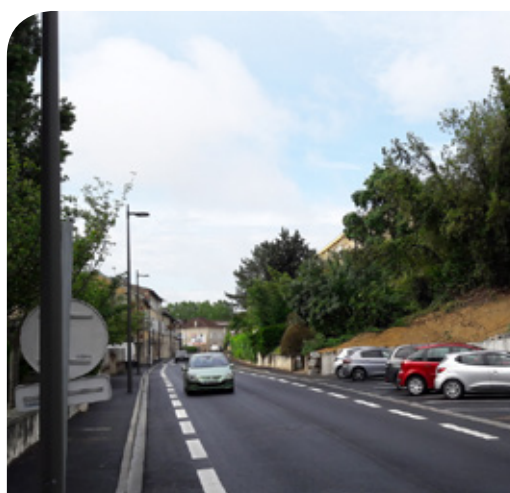
photos avant et après travaux
