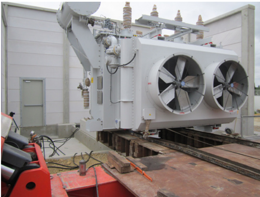
Mise en place du transformateur 63000 Volt / 20000 Volt au futur Poste-source de Jalis à Auch
